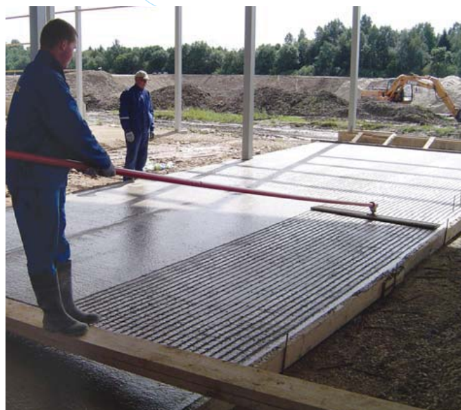
Нанесение уникальной поверхности полов
