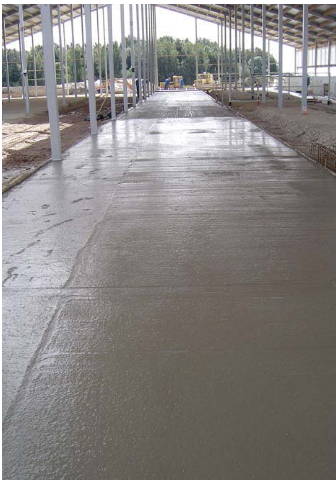
Бетонный пол в стадии завершения
