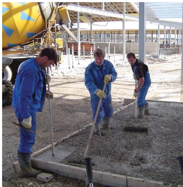
Укладка бетона с армированием Barchip
